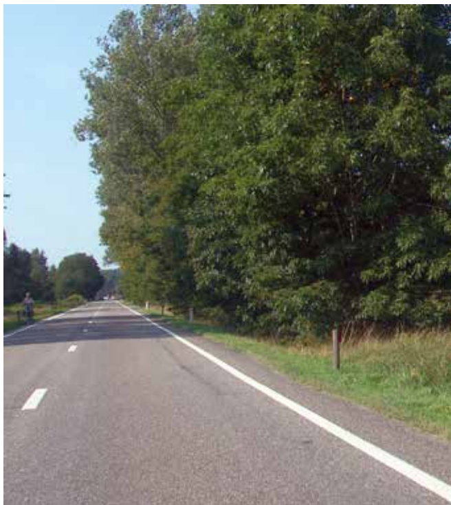
Aanleg fietspad Rotemerlaan
