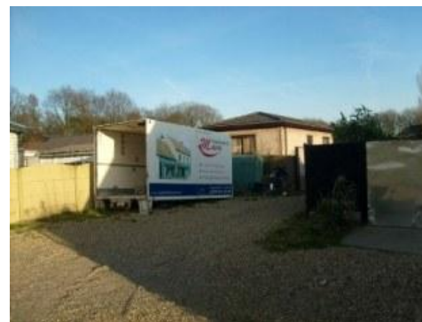
Oorspronkelijke draadafsluiting is verdwenen
